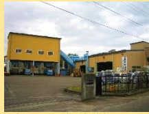
新発田広域不燃物処理場
