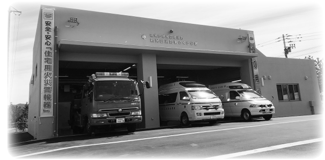
消防 庁舎再編事業 さくら分署開所
