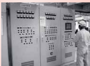
新発田衛生センター 設備点検作業
