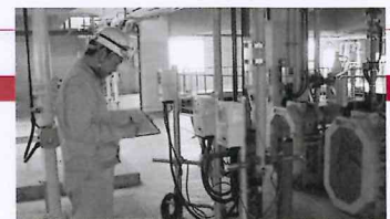
新発田衛生センター 設備点検作業
