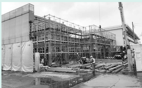
▲旧出張所の解体後に同じ場所で建設工事を進めています。
