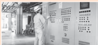
中部衛生センター
