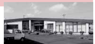
旧新発田衛生センター
